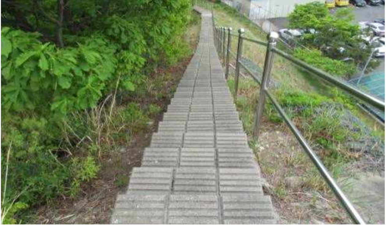
4+800~900 지점 : 1소단 소단배수로 상태양호(안전 울타리 상태 양호)
