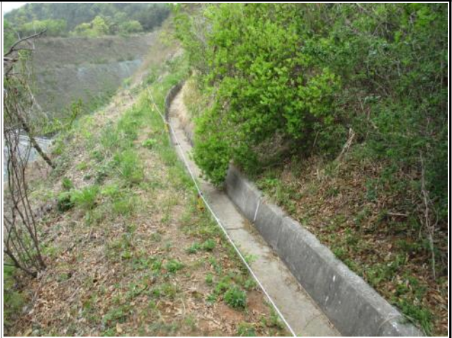
⑫ 4+720~760 지점 : 산마루측구 상태 양호
