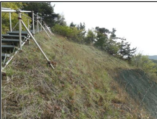
⑨ 4+930 지점 : 4소단상부 식생상태 양호
