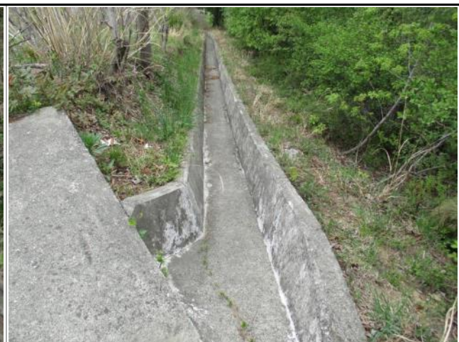
④ 4+980 지점 : 산마루 측구 전경
