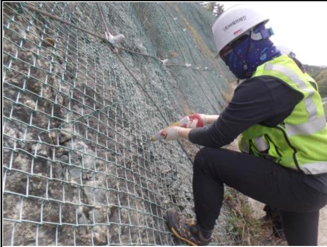
⑤ 4+980 지점 : 2소단 상부 반발경도 측정
