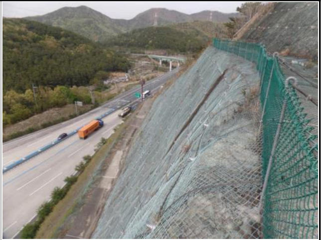
⑥ 4+920 지점 : 2소단 상부 낙석방지책 및 낙석방지망 설치상태 양호
