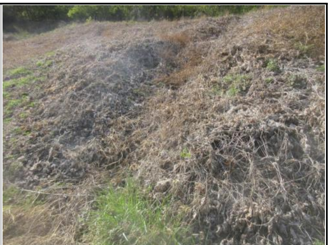
⑩ 4+720 지점 : 2소단 수직도수로 상태 보통
