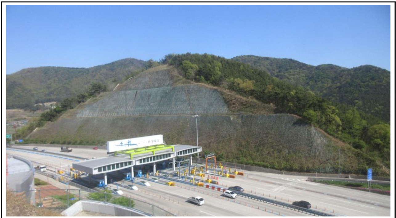
〈그림 1.1-2〉 대상비탈면 전경
