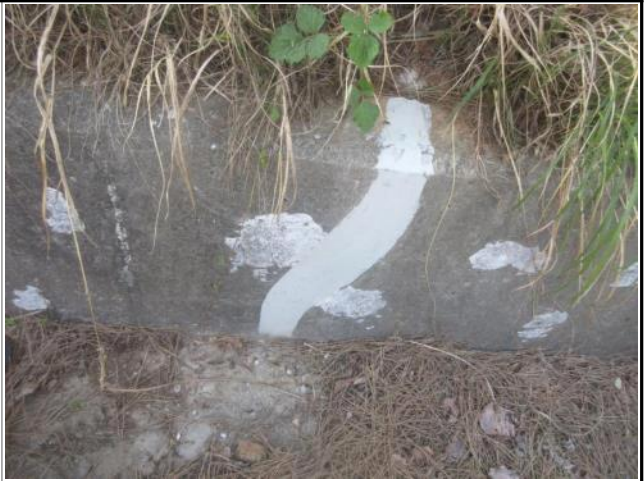
㉕ 4+770 지점 : 상부 배수로 균열 보수완료
