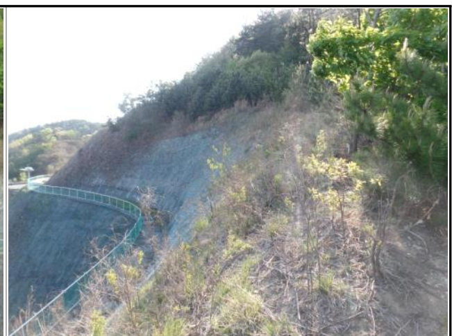
㉒ 4+810 지점 : 상부 자연사면 전경
