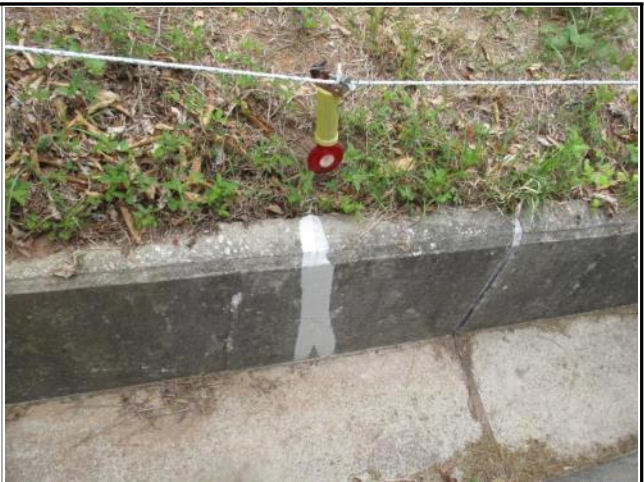
⑭ 4+770 지점 : 배수로 균열 보수 완료
