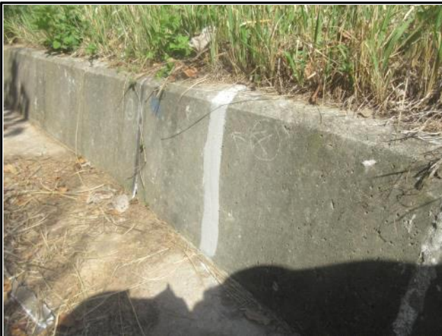
㉖ 4+720~730 지점 : 산마루측구 균열보수완료
