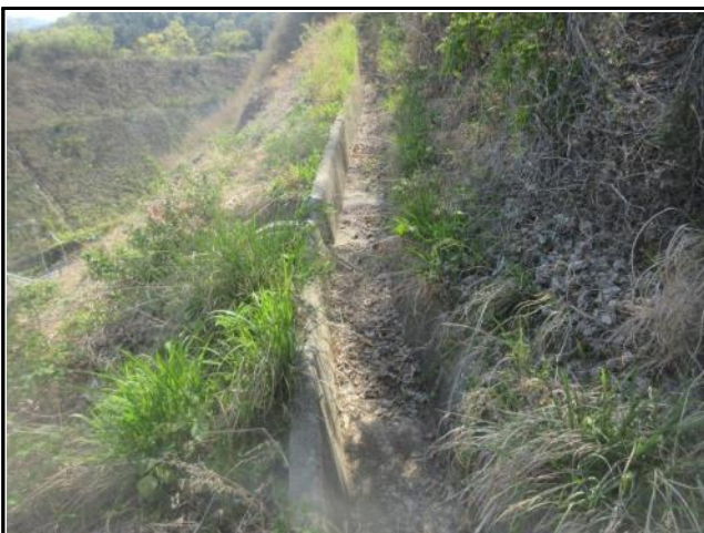
㉗ 4+710 지점 : 상부 배수로 보통
