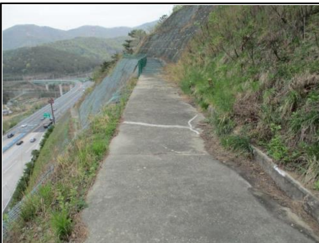
③ 4+900 지점 : 2소단측구 전경
