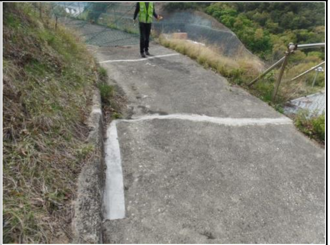
⑫ 4+960 지점 : 2소단 배수로 균열 보수 완료
