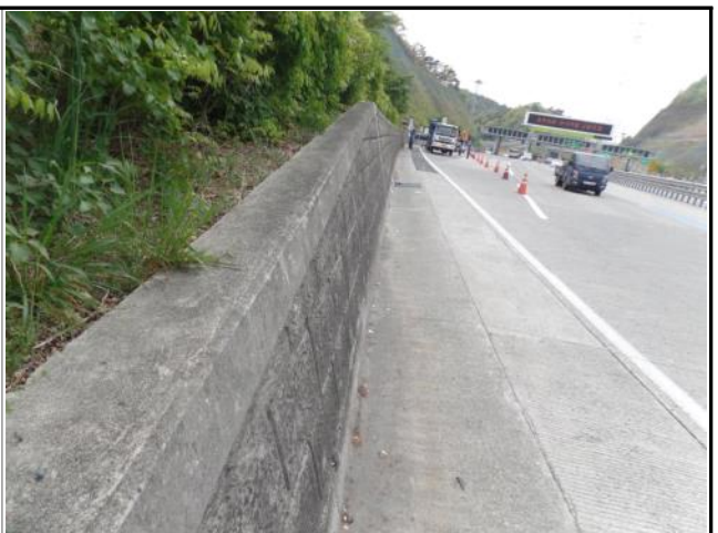
⑯ 비탈면 하부 옹벽 전경
