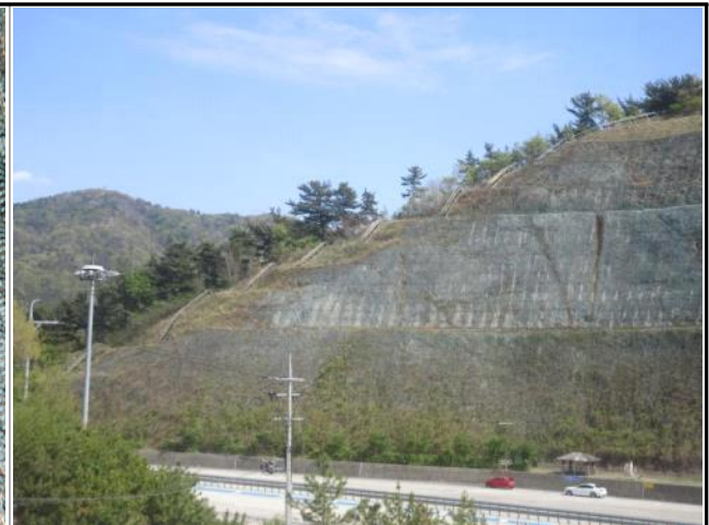
⑭ 5+020~930 지점 : 점검로 계단 전경
