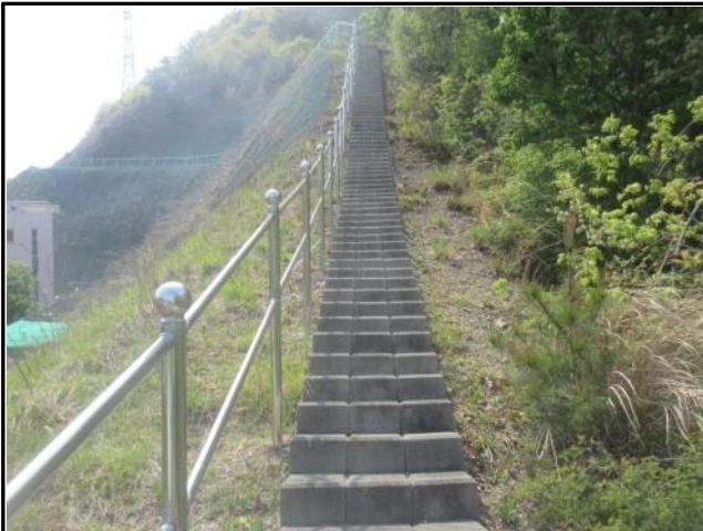
㉕ 4+900 지점 : 1~2단 점검계단 상태 양호
