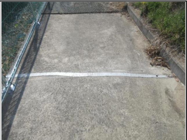
㉖ 4+820 지점 : 1소단배수로 균열 보수 완료
