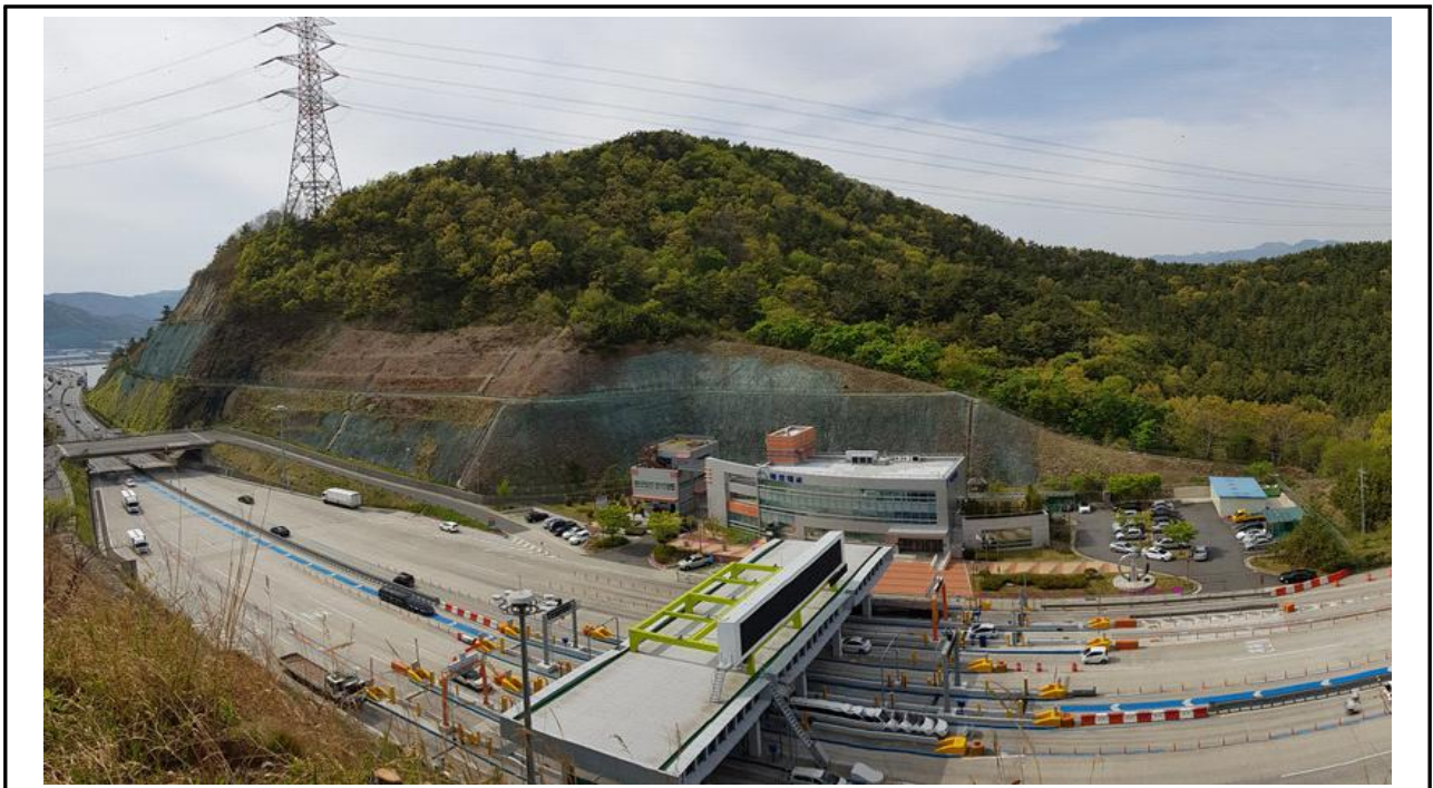
〈그림 2.1-2〉 대상비탈면 전경
