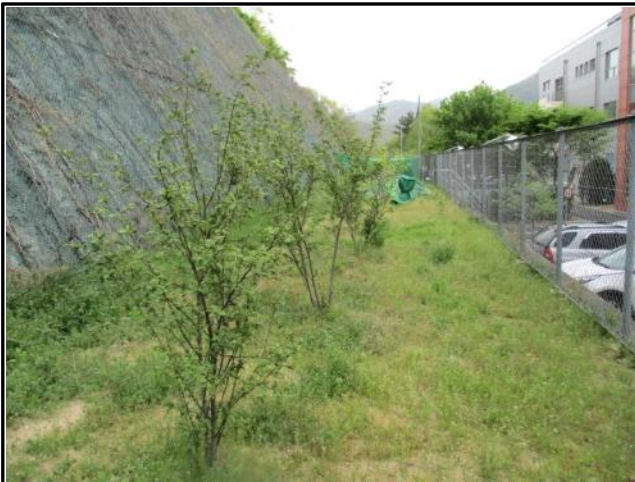
⑲ 4+800~900 지점 : 하단부 이격거리 전경
