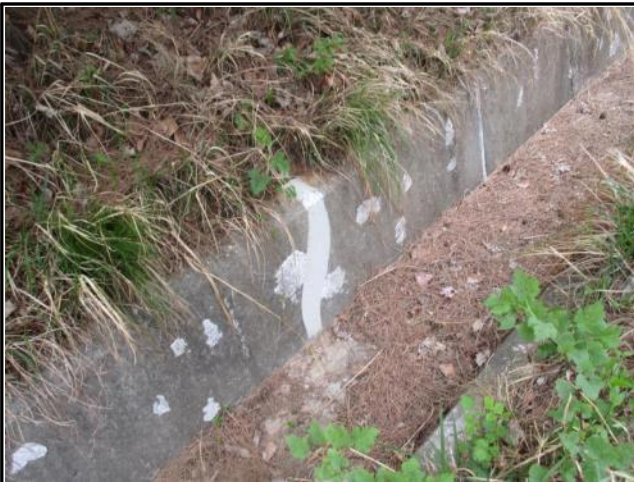
⑬ 4+760 지점 : 배수로 균열 보수 완료
