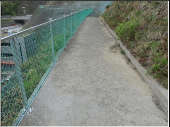
⑥ 4+800~900 지점 : 1소단 소단배수로 상태양호(안전 울타리 상태 양호)
