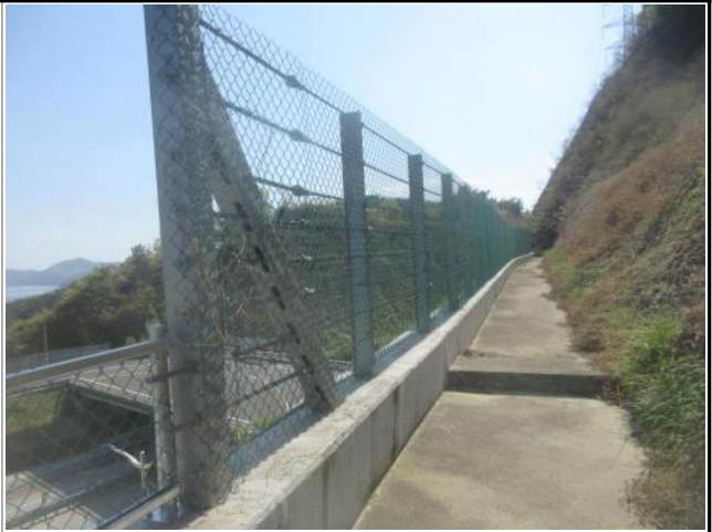
㉔ 4+640~710 지점 : 1소단 낙석방지울타리 상태 양호
