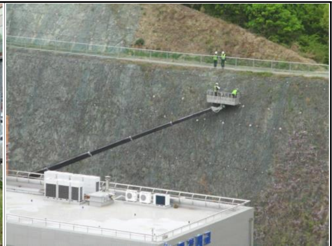
⑳ 1구간 고소차 작업 전경
