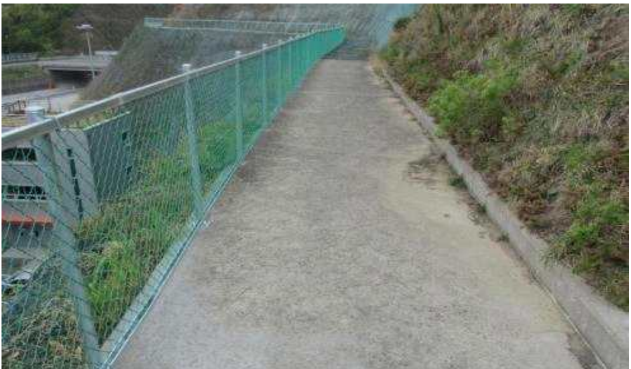
4+800~900 지점 : 1소단 소단배수로 상태양호(안전 울타리 상태 양호)
