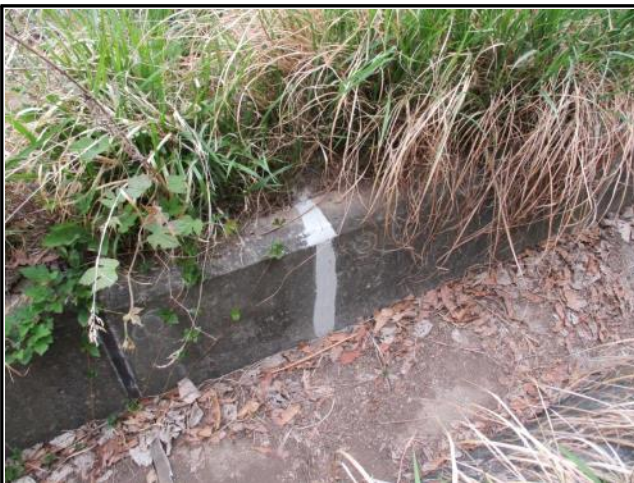
⑮ 4+720 지점 : 배수로 균열 보수 완료
