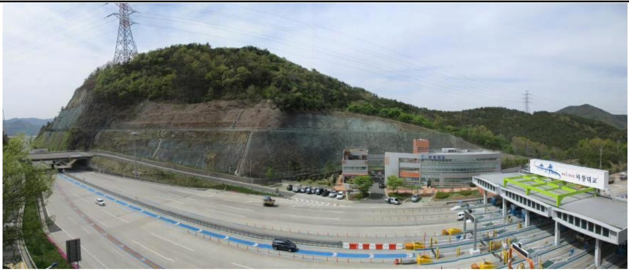
마창 절토사면(영업소 뒤) 전경
