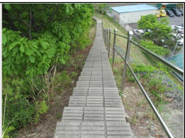
④ 4+840~900지점 : 1단 점검계단 상태 양호
