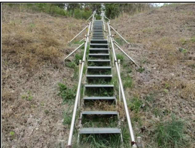
⑨ 4+740 지점 : 2~5단 점검로 상태 양호
